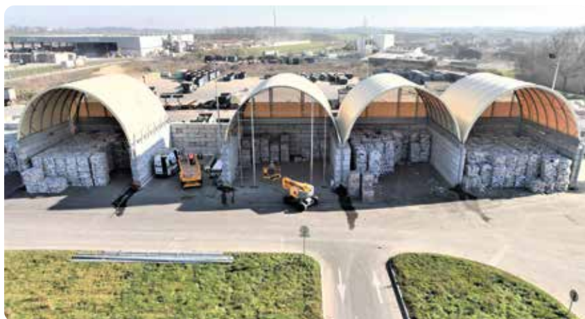
La plateforme nouvelles matières de Semardel accueille les matières issues du tri sélectif (poubelle jaune) avant leur départ vers les filières de recyclage.
